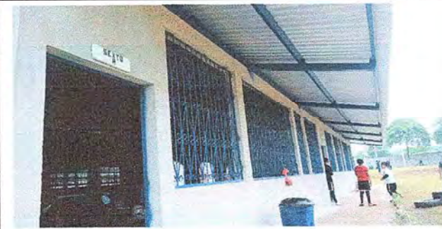
Foto 4: Se puede observar que las costaneras ya estan instalados.
